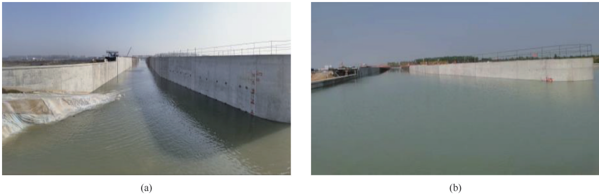
图10 引江济淮通航渡槽水桥渡槽充水试验照片
