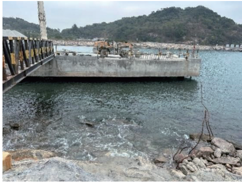
(a) 现场暴露位置
