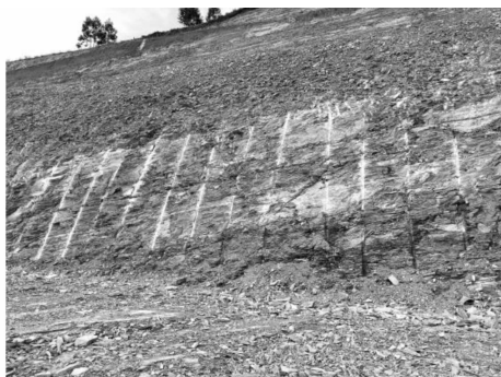
图 6 开平粉砂岩砂矿新技术预裂爆破效果 Fig. 6 New technology blasting effect in Kaiping
