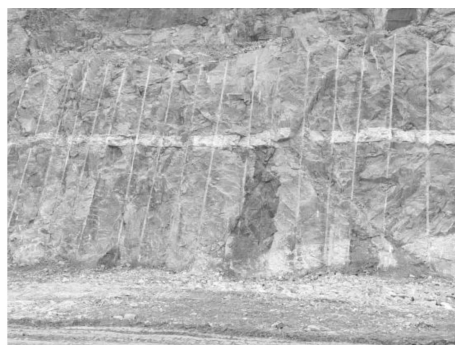
图 8 阳西片麻岩矿新技术预裂爆破效果 Fig. 8 New technology blasting effect in Yangxi
