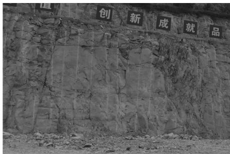
图9 揭阳花岗岩矿传统预裂爆破效果
