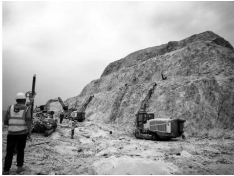
图 3 英德下太石英砂矿传统预裂爆破效果 Fig. 3 Traditional presplitting blasting effect in Yingde
