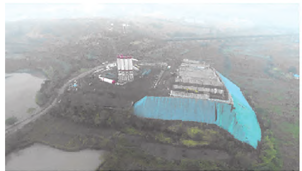
图2 建设中的混凝土拌合站
