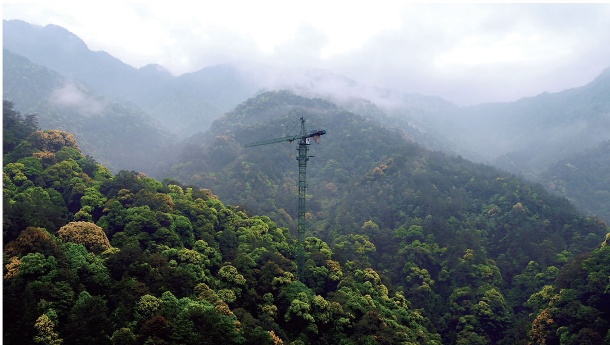
安装在古田山样地的塔吊 供图 / 中国科学院植物研究所
