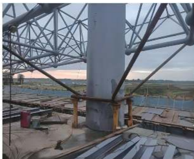
图 13 网架增强加固系统图
