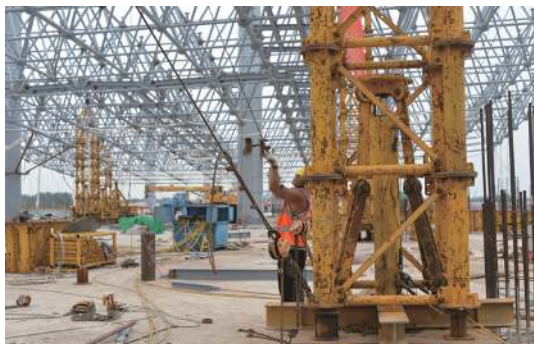
图 16 原始的调节方式需要直接拉动钢缆
