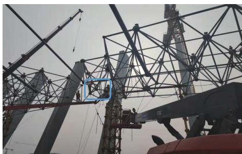
图 18 现场使用改良后的焊接支撑装置进行单元网架拼接
