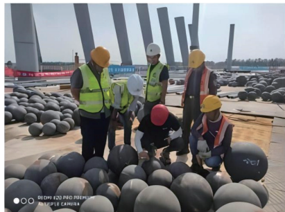
图 2 焊接球构件进场验收
