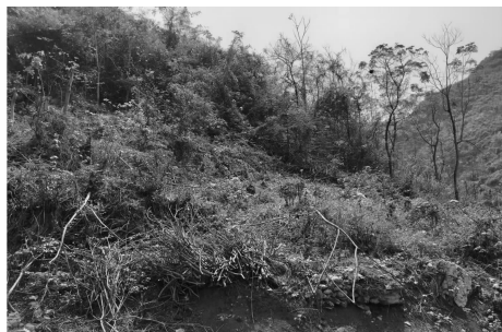
图4 危岩下缓坡面的灌木植被及生根石地貌
