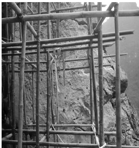
图6 危岩上炮孔实际分布
