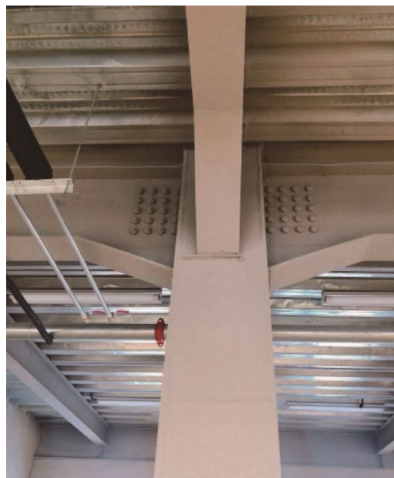
图1 既有钢框架梁柱节点
