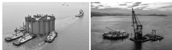
图 17 设置钢沉井托运与安装
