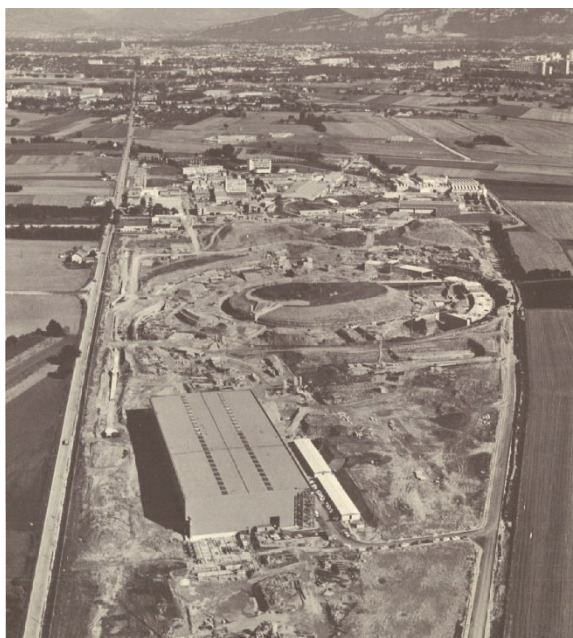
图9 交叉存储环时期园区鸟瞰图 [14]
