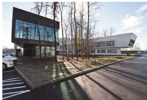
图30 欧洲核子研究中心774号楼外部视图 [7]
