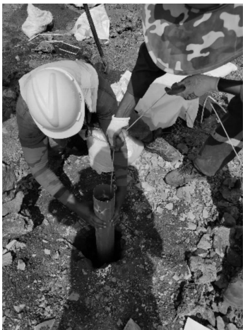
图 3 采用成品乳化吊装及防静电 PVC 管 组合的方式约束装药
