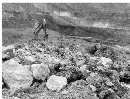
图 2 蜂窝状矿石区域爆破后二次破碎图片
