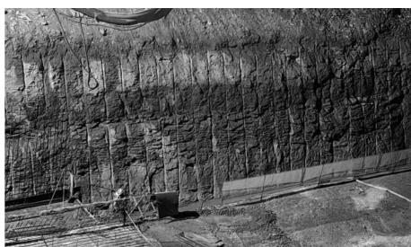
图7 典型齿槽边坡半孔分布情况
