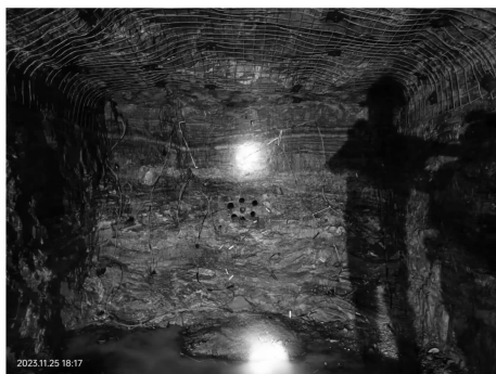
图 2 井下小断面开挖融合延时起爆网路现场
