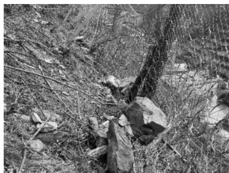
(b) 第二层防护网防护效果 (b) Protective effect of the second layer net
