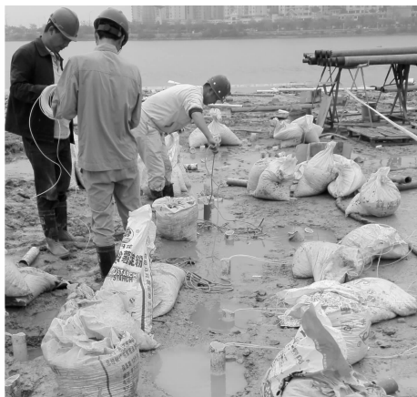
图2 爆破现场装药图
