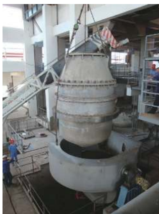
图8 第二代卡尔多炉现场安装对接
