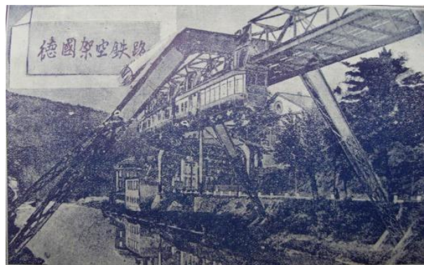
图4 德国架空铁路 [56]
