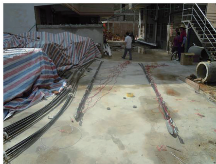
(b) 应变计全部安装至钢绞线现场
