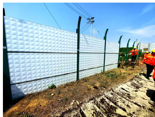
图10 仿生声屏障板结构工人现场安装
