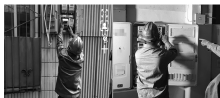
图6 电能表现场更换照片
