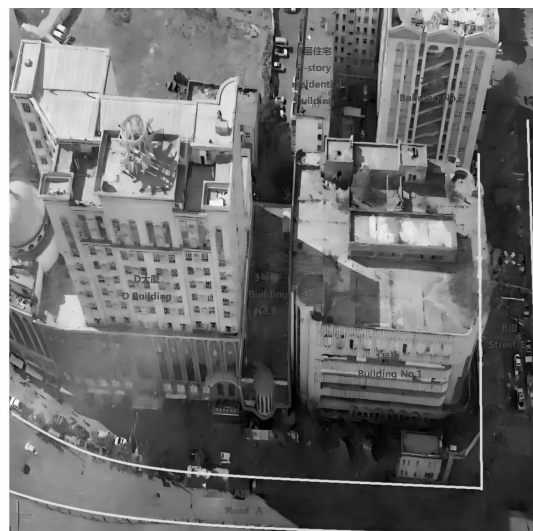
图 4 3 号楼房照片和周边环境情况
