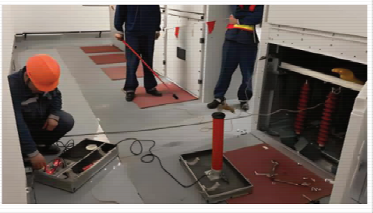
图1 区域性输变电网络架设
