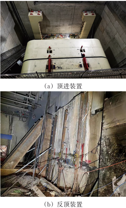
图 4 密贴增建顶管通道现场图
