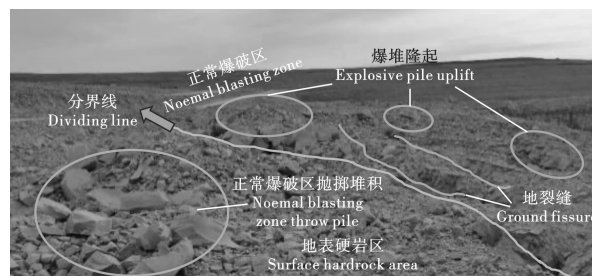
图 4 改进前地表硬岩破碎效果
