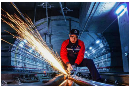
图1 地铁轨道线路养护维修现场图
