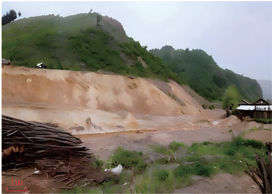
图2 项目区现场情况图
