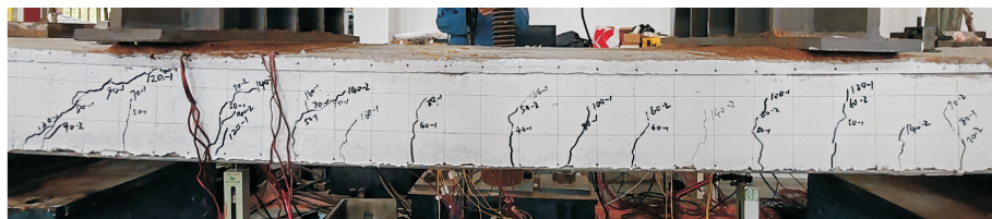
图7 试件裂缝形态图
