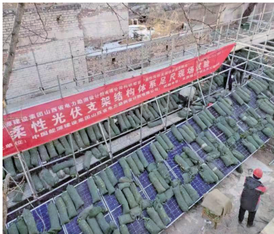
图1 柔性光伏支架静载试验现场照片
