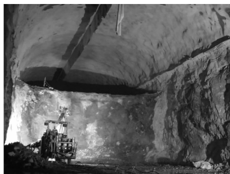
图 4 洞室中层开挖施工图
