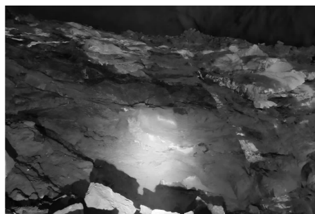
图 1 岩体中存在的水平结构面
