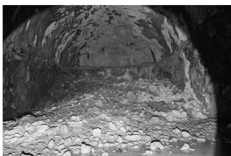
图22 优化爆破方案后爆堆块度
