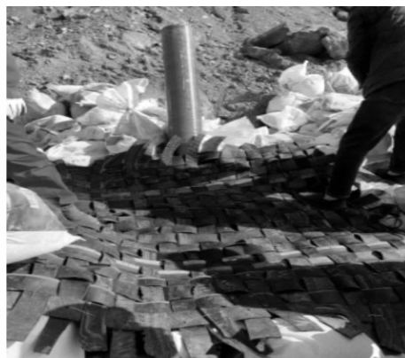
图 15 靶向泄压管安装
