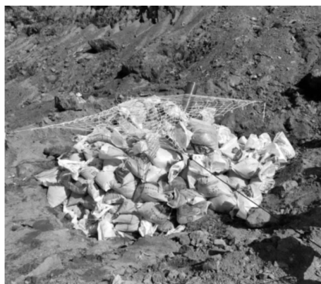
图 16 柔性防护网安装
