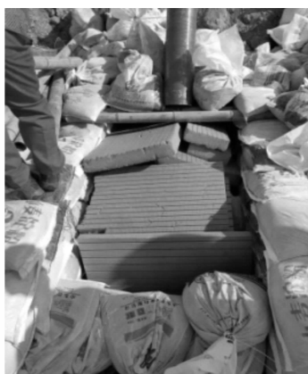
图 14 EPS 泡沫填塞
