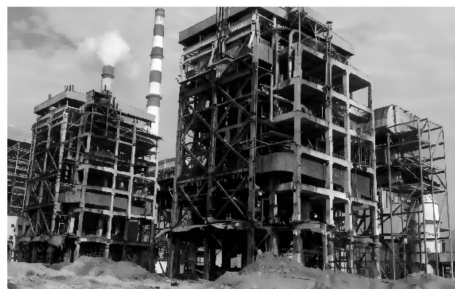
图 1 待拆除锅炉房
