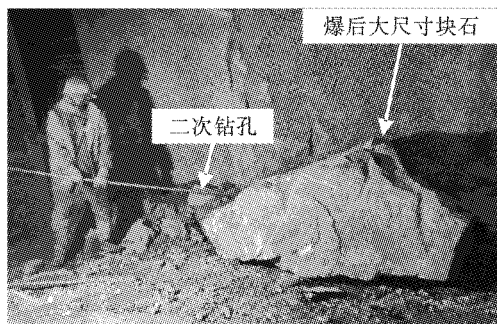
图5 原掏槽爆破爆后大尺寸块石
