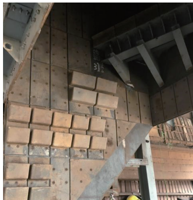
图3 环冷机给矿漏斗改造现场效果
