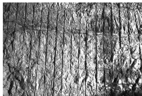
图 5 中层预裂爆破效果
