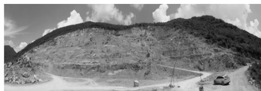
图1 塘垭水泥灰岩矿露天边坡
