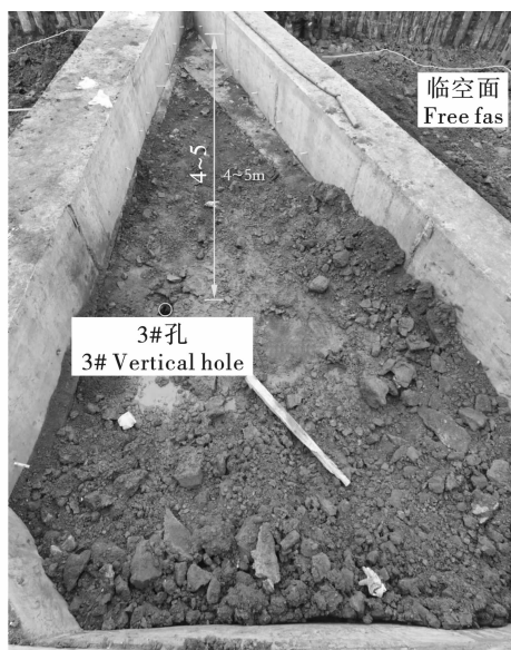
图 16 3#竖直孔爆破效果 Fig. 16 No. 3 vertical borehole blasting effect
