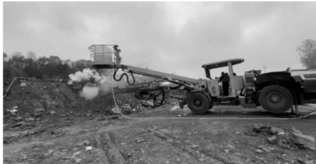
图 12 水平孔测试现场破岩过程 Fig. 12 Rock breaking process at the horizontal borehole test site
