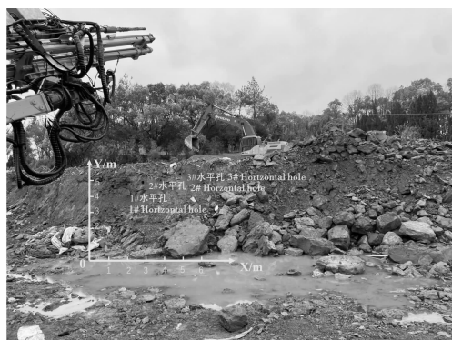
图9 水平孔破岩现场及布孔位置图
