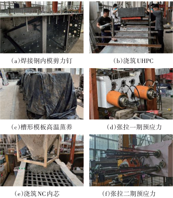
图 5 试验梁制作过程 Fig.5 Fabrication Process of the Test Beam
